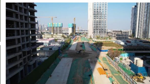
五六期管网工程
